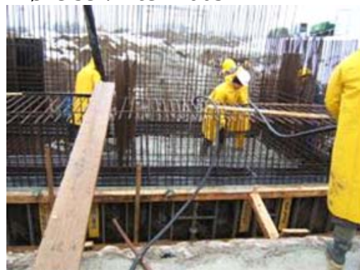
Støbning af betonfundamenter
